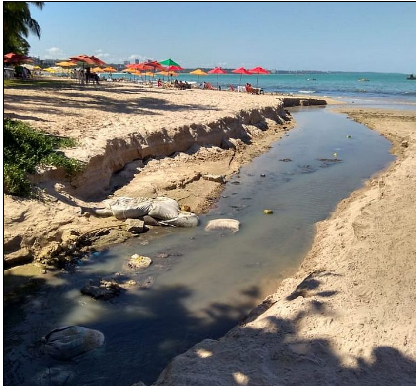
Figura 10 – Canaleta de despejo pluvial, lançando efluentes na Praia de Pajuçara em 2019.
