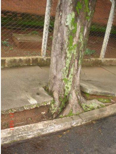
Foto 1, 2 e 3 – Raízes destroem calçadas; Conflitos entre arborização e iluminação; Fonte: CROSARA, 2010.
