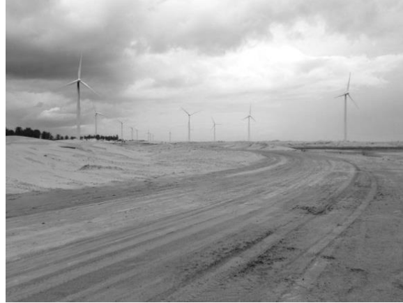
Figura 2 – Compactação do campo de dunas. Eólica Morgado
