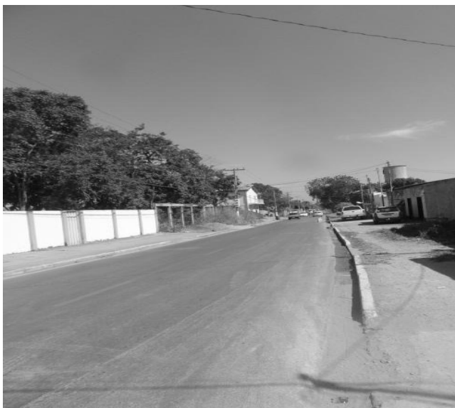
Figura 3: Obras de Mobilidade Urbana destinadas ao São Gonçalo Beira Rio: Interligação da Av. Beira Rio à Av. Antonio Dorileo, Ponte sobre o rio Coxipó, Av. Itaparica, Rua Camburiú, Rua Cabeceiras.
