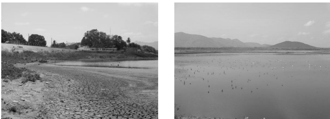
FIGURA 5 E 6: AÇUDE VÁRZEA DA VOLTA
