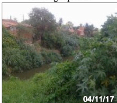
Figura 13 – Edificações na margem esquerda do Maranguapinho
