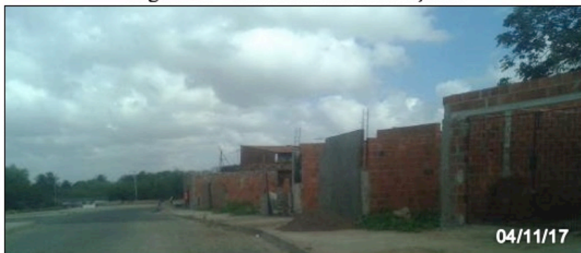
Figura 20 – Ponto de reurbanização 3
